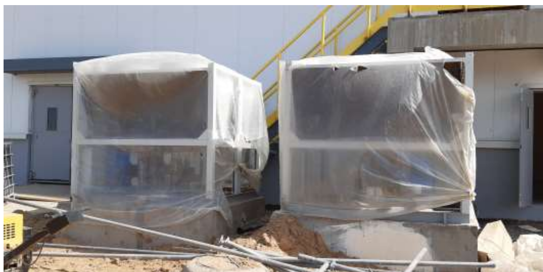
Рисунок 6 – Процесс монтажа моноблочного чиллера снаружи здания
