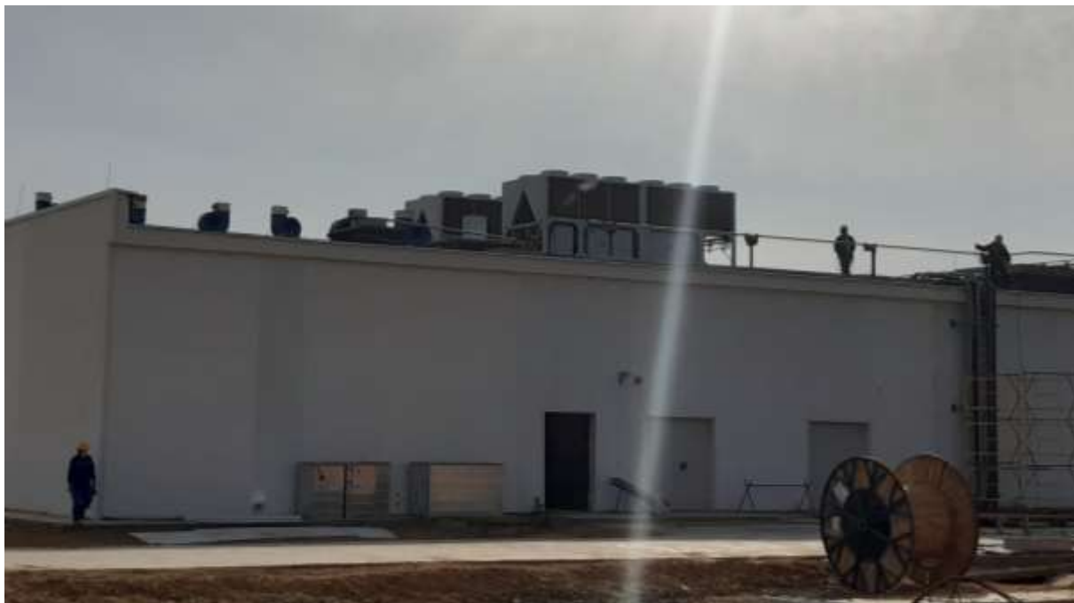
Рисунок 7 – Процесс монтажа моноблочного чиллера на кровле здания
